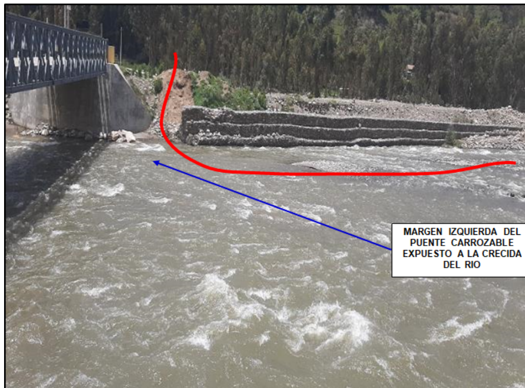
FIGURA N° 02: SE VISUALIZA EL PUENTE CARROZABLE VULNERABLE POR LA CRECIDA DEL RIO Y LA FALLA DEL MURO DE GAVIÓN.
